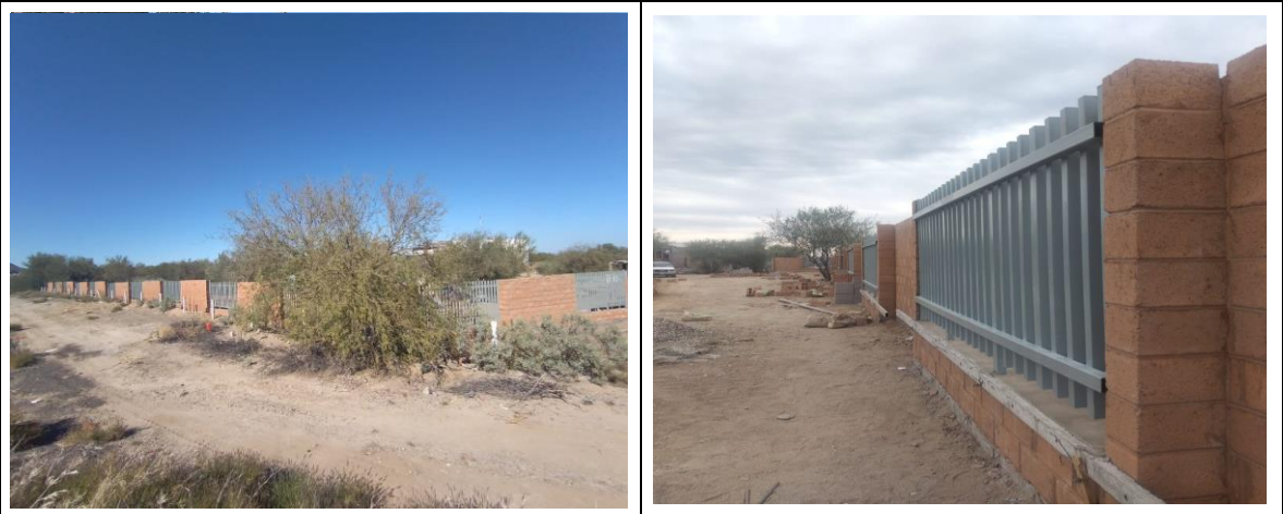
Construcción de fachada de acceso a las oficinas del CRESO.
